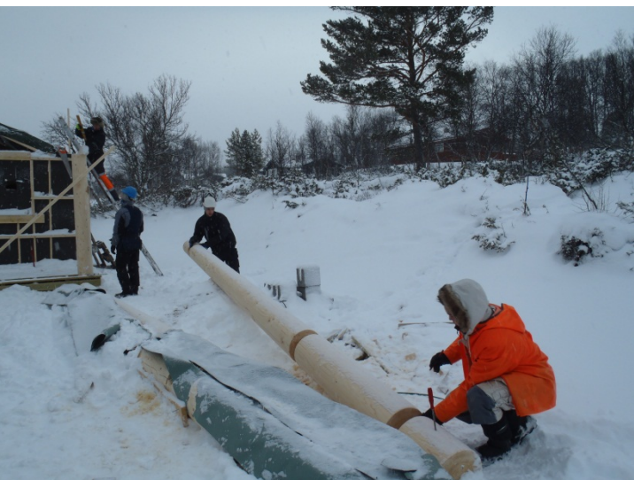
Uthaking og montering av takåser, Hånesåsen.
