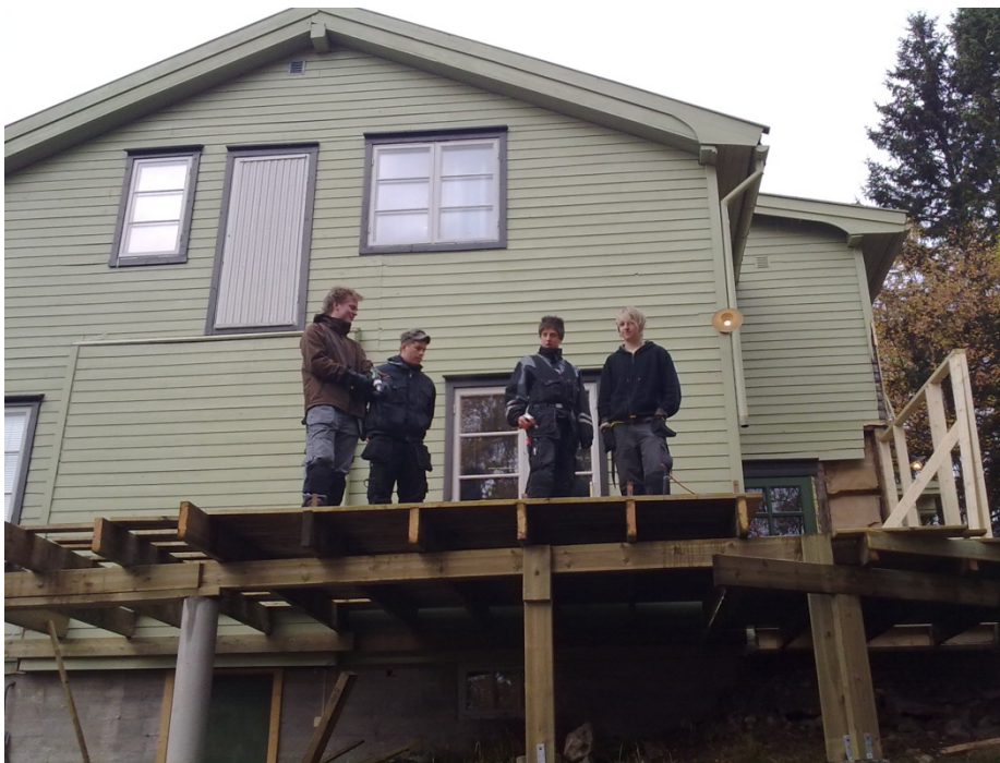
Tilbygg m. veranda 2
